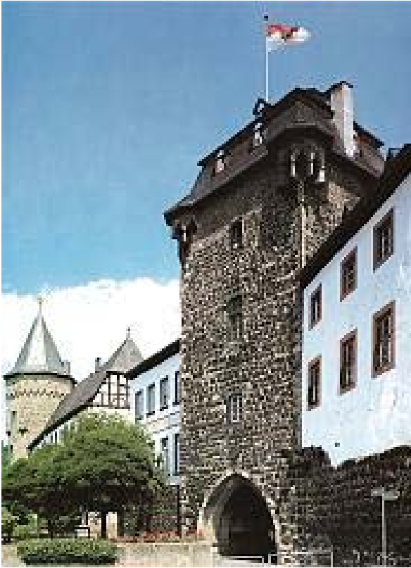
Das Rheintor mit ehemaligem Zollhaus. Hier sind beeindruckende Hochwassermarken an Außen- und Innenseite angebracht.
